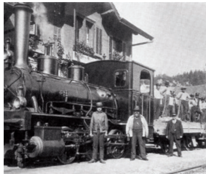
Die Dampflok E 3/3 Nr. 1 mit Bauzug in Menznau.
